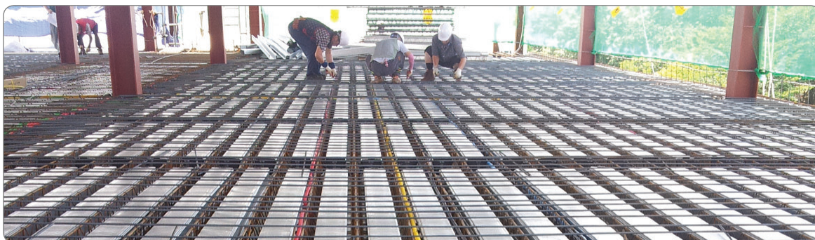
비채메가 현장 시공 전경
