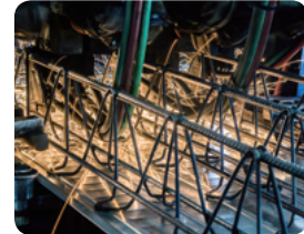
데크 자동 용접
